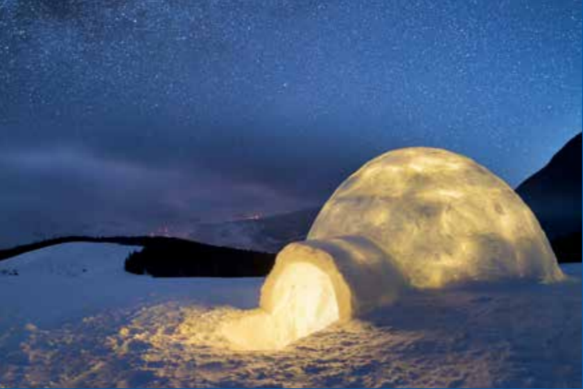
▲加拿大原住民因紐特人常住的冰屋，屋頂圓圓的像顆球。蓋時用雪砌磚，按規律堆疊，最後在表面潑水，水會滲入雪磚縫隙並且凍結成冰，堅固的冰屋就完成了，而且誰都無法爬上屋頂，因為太滑了！
