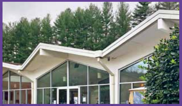
▲這種從兩側往內傾斜的構造叫做蝴蝶屋頂或V屋頂，下雨時可以將雨水集中到中央的凹處，再從排水管流掉，避免積水。在少雨的地區，也能用來收集水，供給日常生活所需。
