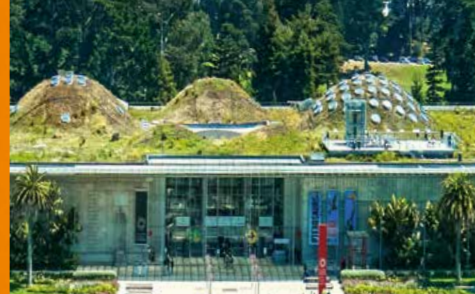
▲加州科學院在屋頂上種滿植物，是世界知名的綠屋頂，也稱活屋頂，能提供良好的隔熱，減少開閉暖氣的需求。另外還設置了採光的天窗，讓自然光照射室內，節省用電。
