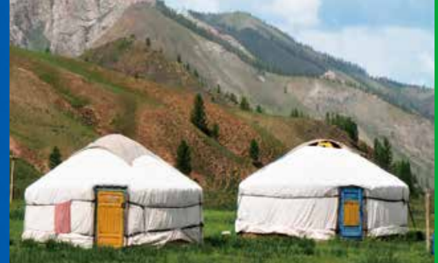
▲蒙古包是中亞游牧民族的傳統住房，拆裝容易，適合搬遷，圓拱形屋頂能承受大雪的重量與強風。屋頂中央有天窗，天氣熱時將蓋在上面的皮革掀開，就能排出熱空氣，調節包內的採光和溫度。
